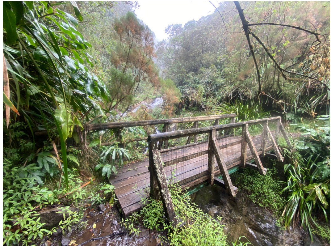
PASSERELLE PONT DE CHIEN
